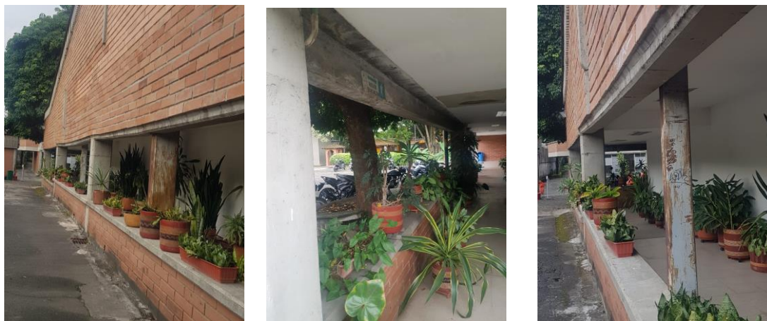
Figura 14. Bloque P19 (Av. Regional).
