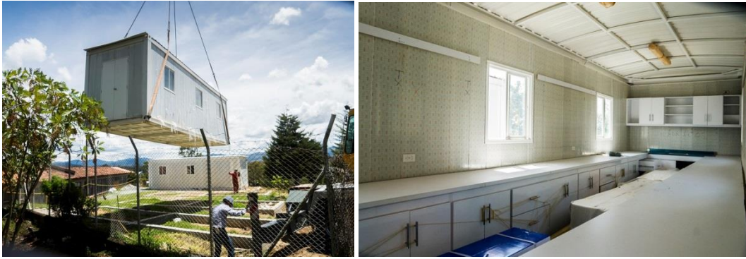
Izquierda: Instalación de laboratorios móviles (contenedores) en Politécnico JIC Rionegro – 2016 Derecha: Vista interior laboratorios móviles (contenedores) Politécnico JIC Rionegro – 2016
